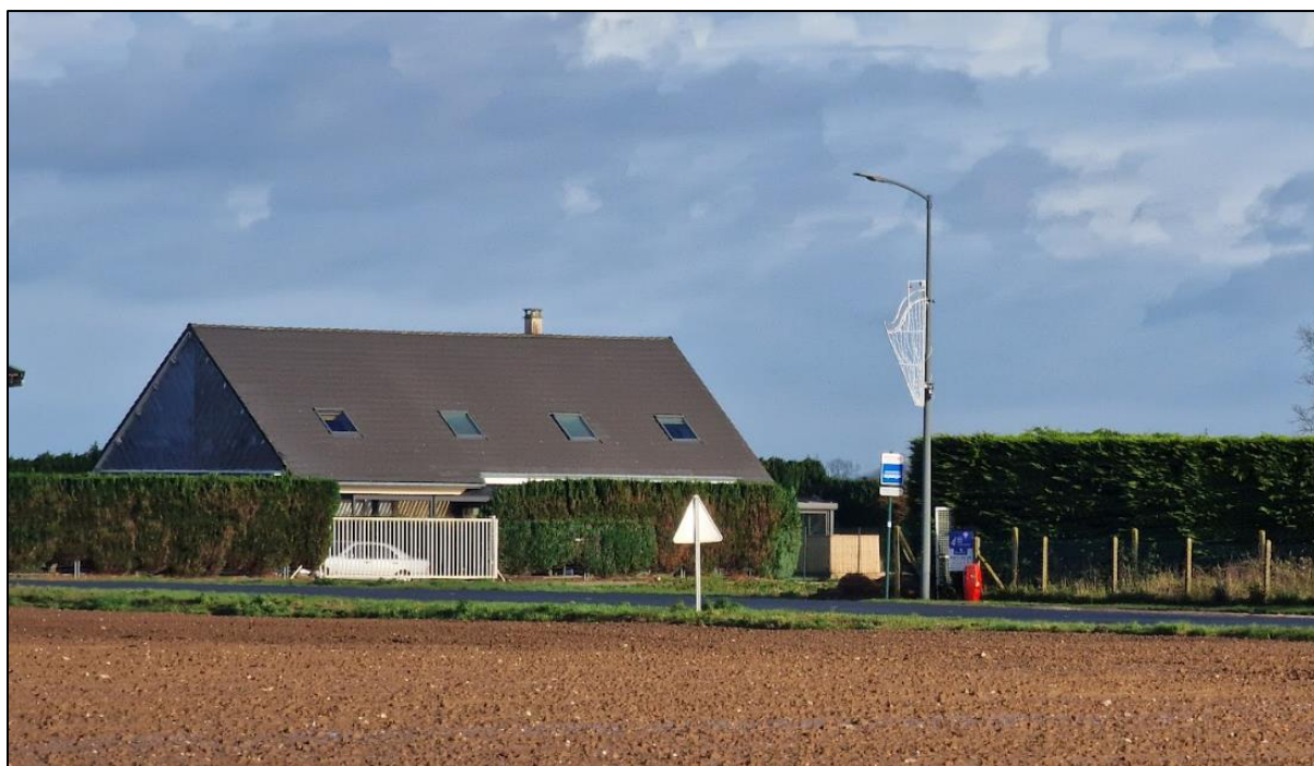
Photographie de terrain - bâtiment en zone Uy le long de la RD54
