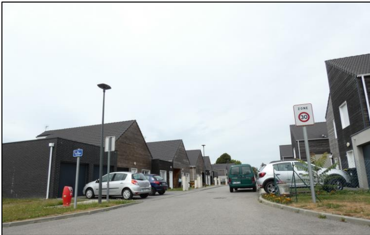
Logements individuels groupés à Saint-Nicolas-d'Alermont (Source : Géostudio)
