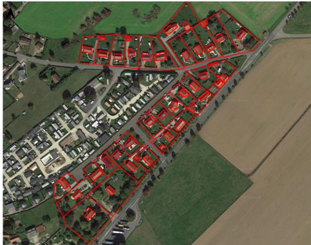
Habitat pavillonnaire en implantation individuelle (Réalisation : Géostudio)
