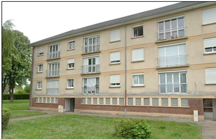
Habitat collectif à Saint-Nicolas-d'Aliermont (Source : Géostudio et Google Maps)
