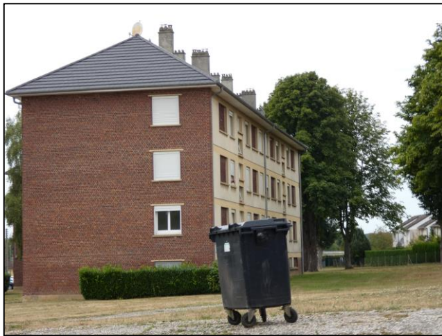
Logements collectifs à Saint-Nicolas-d'Aliermont (Source : Géostudio)
