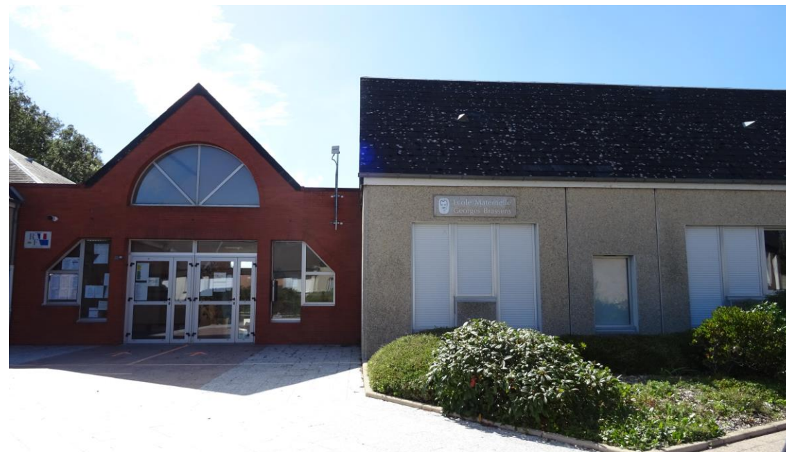
Le groupe scolaire Georges Brassens à Petit-Caux (Saint-Martin-en-Campagne)
