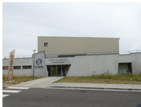
Gymnase à Saint-Nicolas-d'Aliermont
